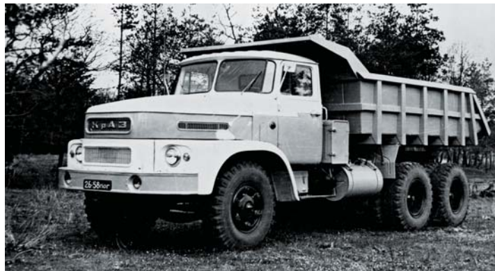
▲ Художественный рисунок и выполненный в 1962 году опытный образец самосвала КраЗ-251, у которого тоже использовали кабину от ЗИЛ-130, но капот и крылья выдержали в духе выпускавшихся тогда кременчугских грузовиков
