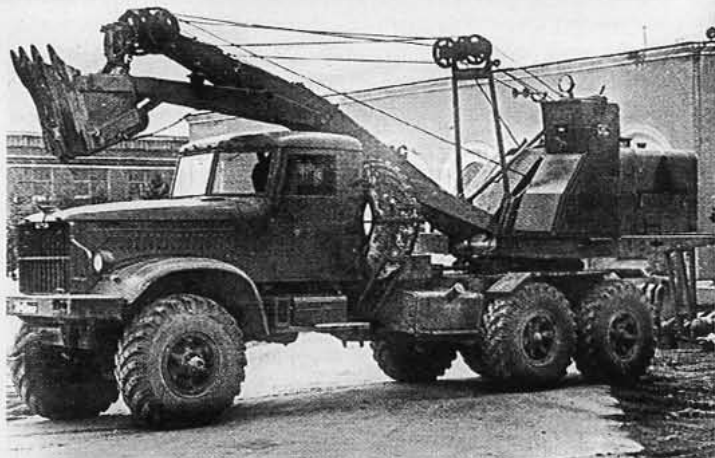
Экскаватор Э-305В с кабиной экскаваторщика в специальном исполнении
