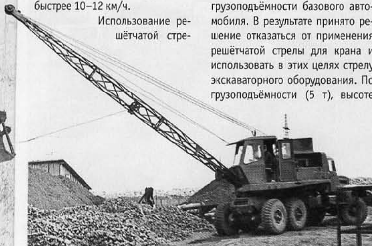
Экскаватор Э-305 на базе ЯАЗ-214 с грейферным...
