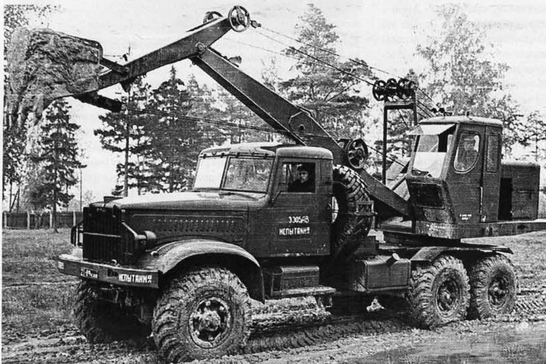
Экскаватор Э-305АВ на базе КраЗ-214Б
