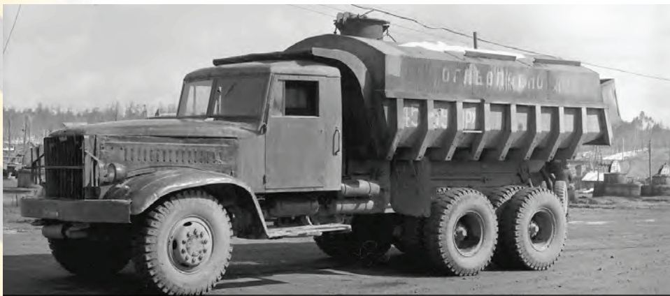
Несмотря на внешнюю схожесть с «222-ым», на фото более современный КраЗ-256 с V8 ЯМЗ-238 и новой самосвальной платформой
